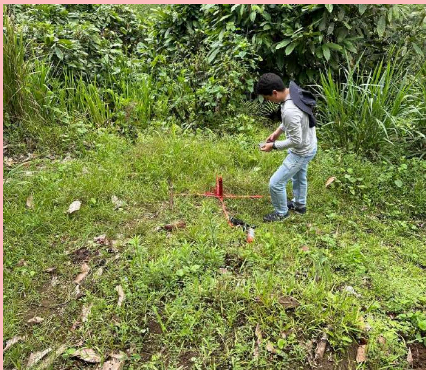
TRABAJOS PREVENTIVOS A LA INTERVENCIÓN EN EL KM 83 SECTOR LELIA VÍA QUITO
