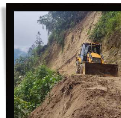
Habilitación de vía
