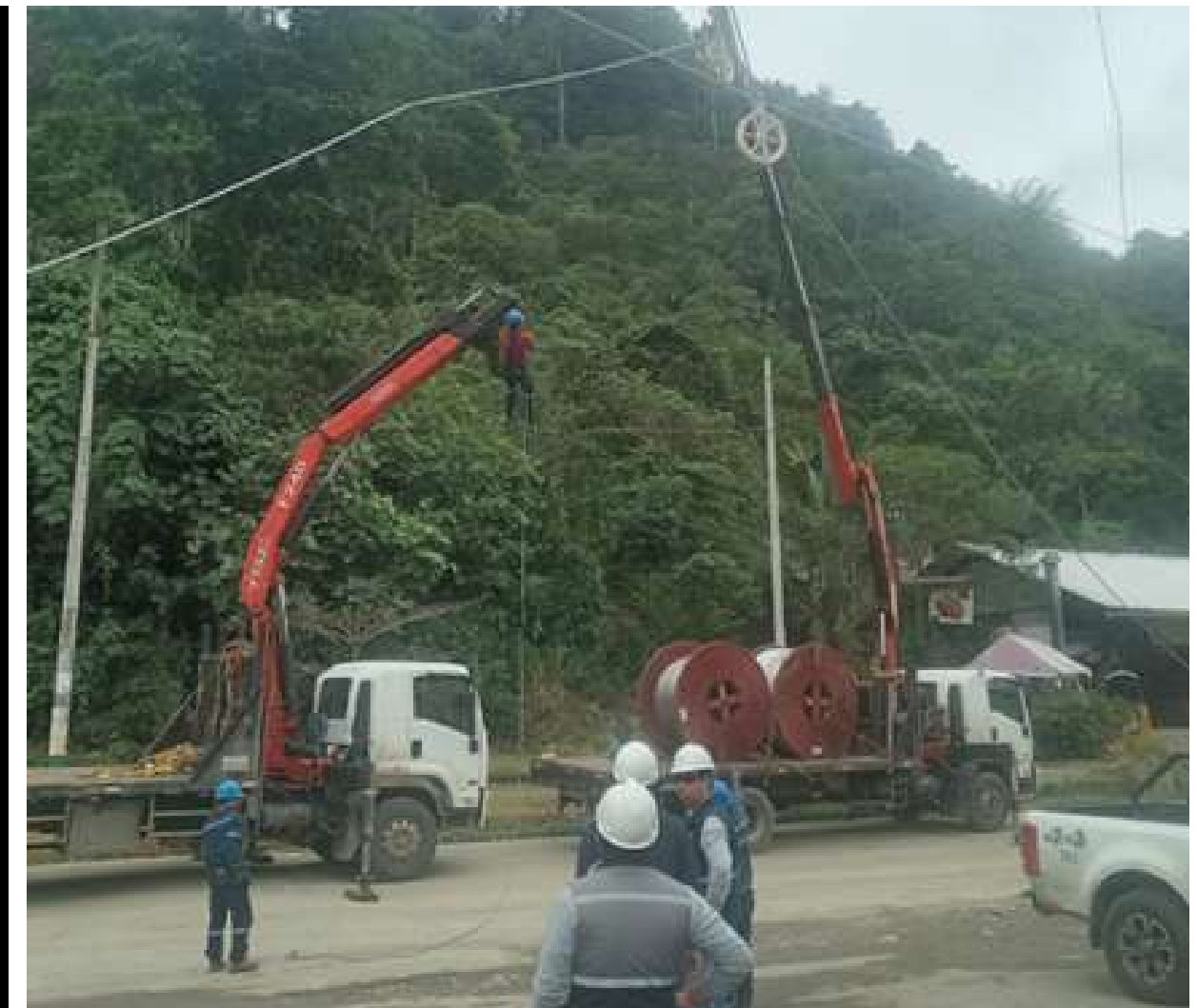
Cambio del cableado de Alta Tensión y remediaciones en la cabecera Parroquial Transelectric
