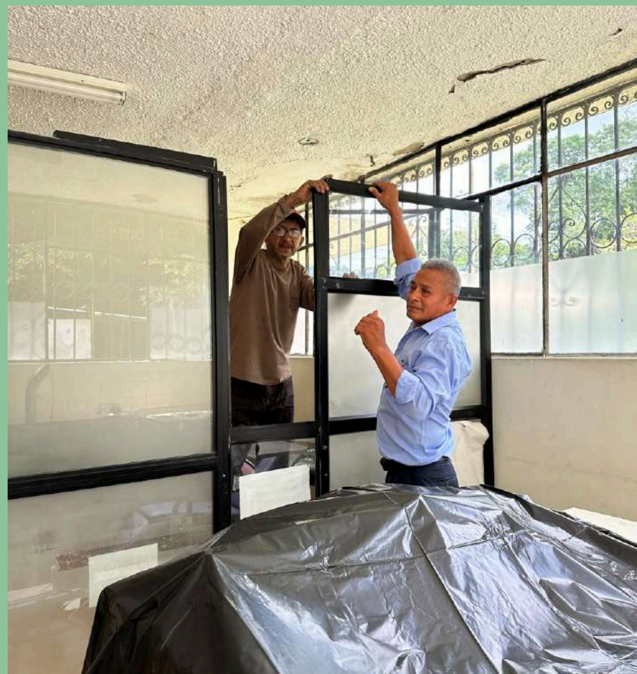
LA READECUACION DEL DISPENSARIO MÉDICO DE LA PARROQUIA ALLURIQUIN
