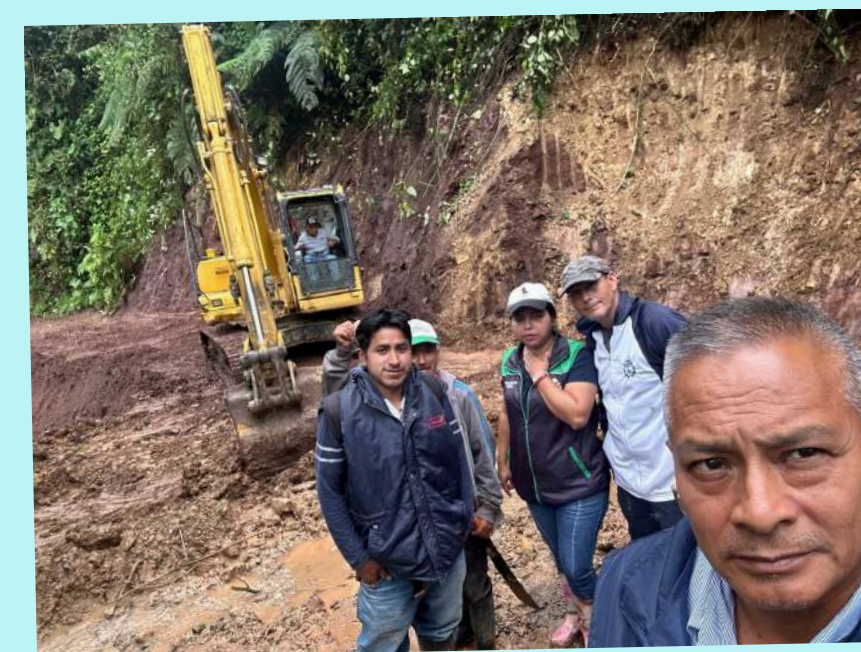
LA GESTIÓN DE MAQUINARIA EN LA PREFECTURA SE PUDO REESTABLECER LA COMUNICACIÓN VIAL EN EL RECINTO CHITOA
