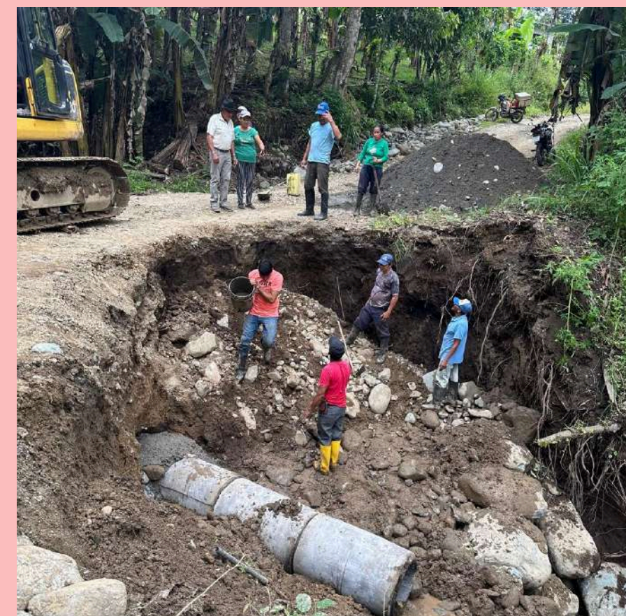
ARREGLO DE ALCANTARILLA EN EL APOYO DE PREFECTURA Y LA COMUNIDAD EN EL RECINTO LUIS FELIPE
