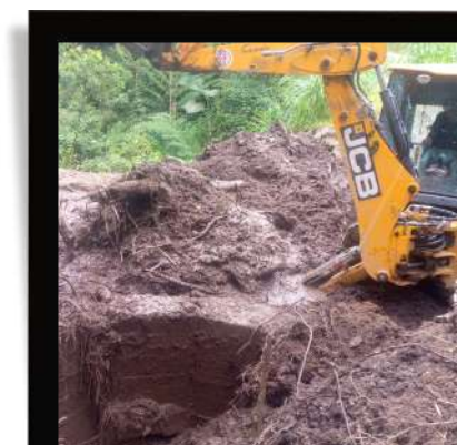
Limpieza de puentes
