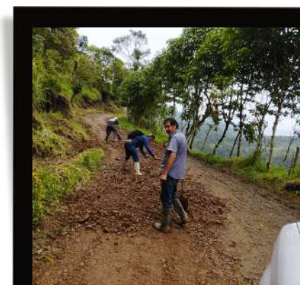
Rebacheo de Via
