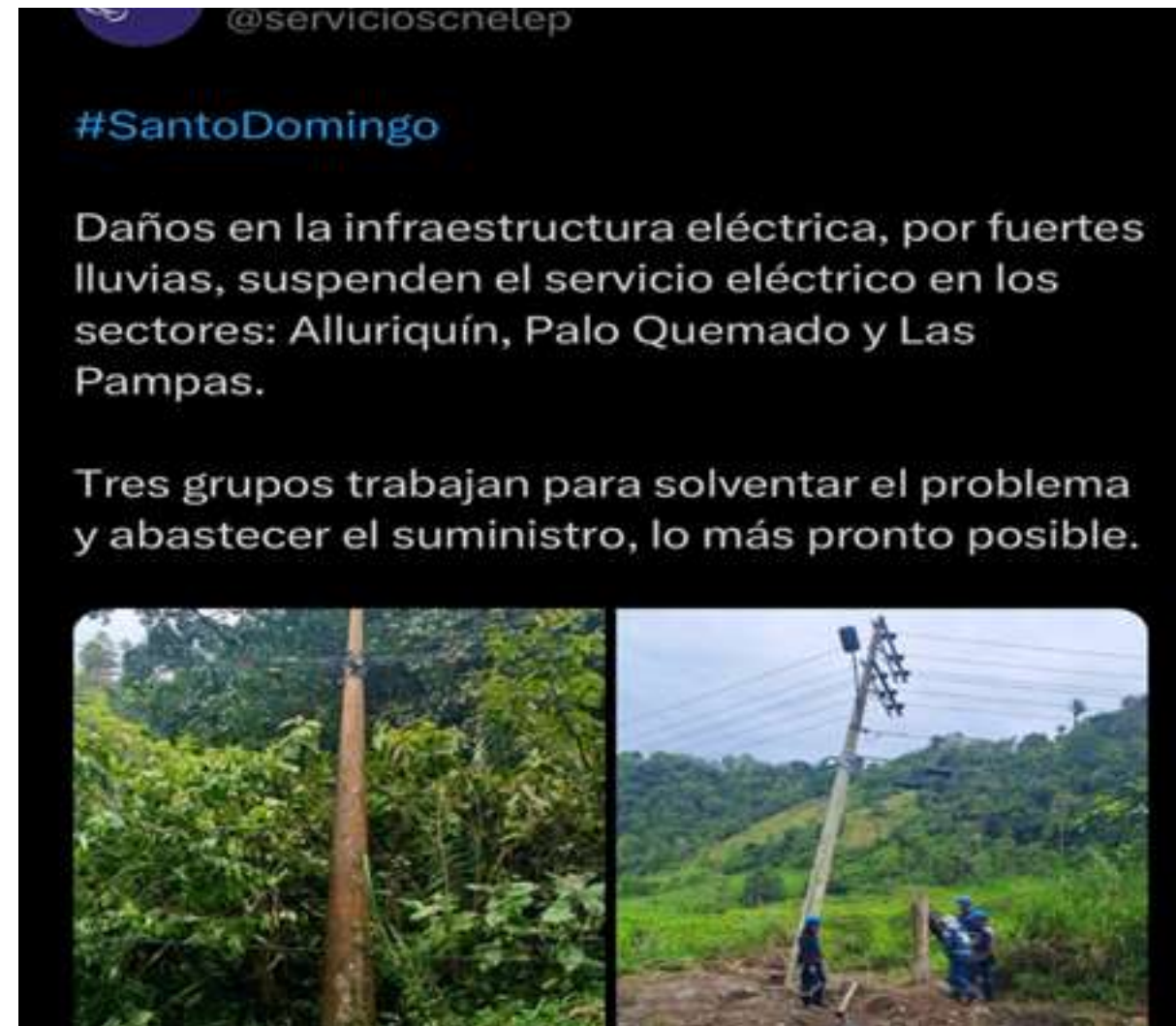
Gestion en CNEC para restablecer el servicio de energia electrica en los recintos
